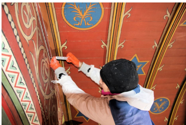
Bouchage des fissures de la voûte
